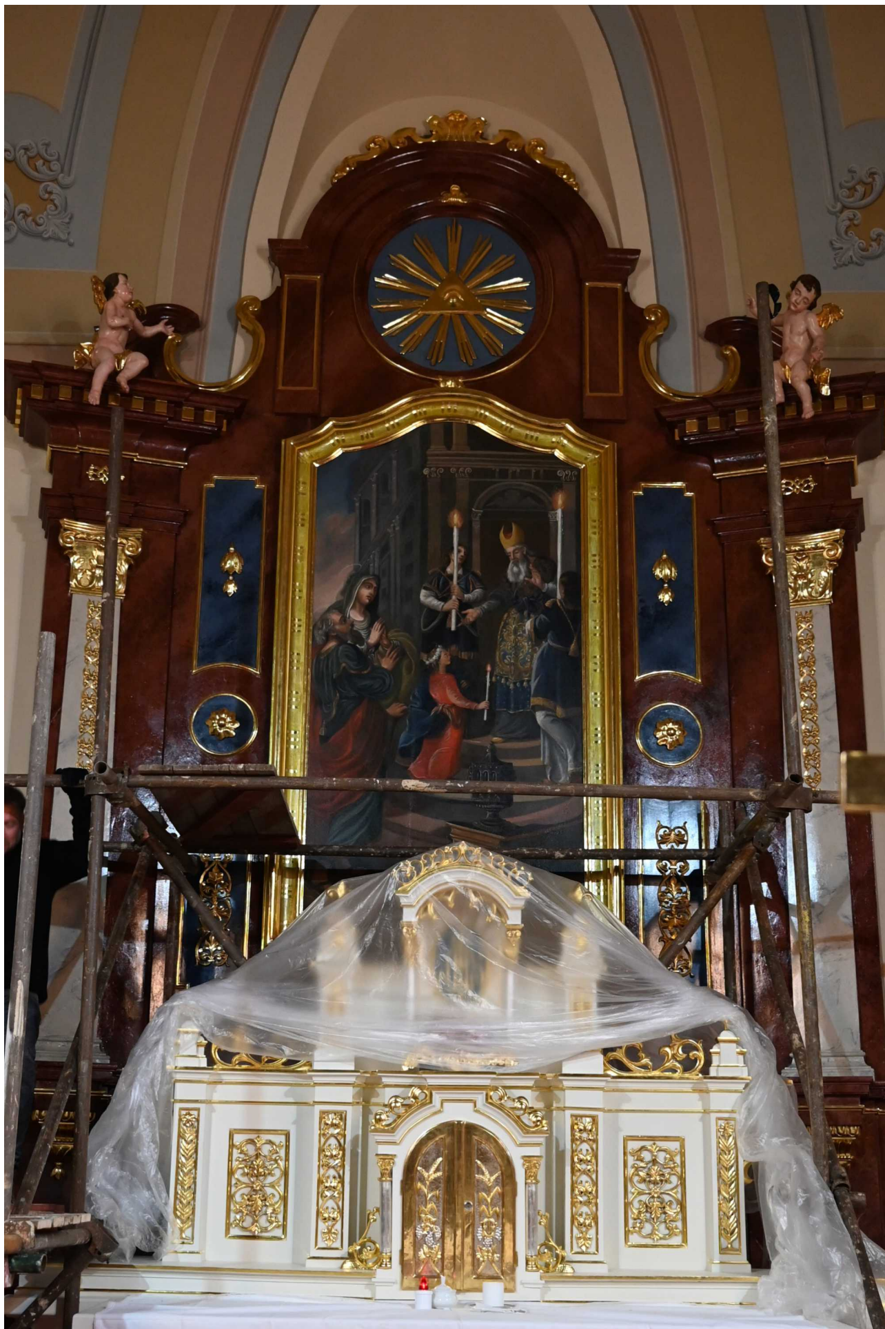
42. Pohľad na oltár po inštalovaní obrazu do oltárnej architektúry
